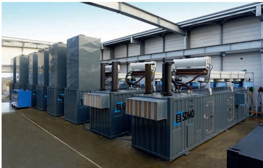
associés aux colonnes d'échappement et de rejet d'air, tous deux rehaussés, assurent une baisse de la température optimisée, sans entraver les entrées d'air de chaque container.
